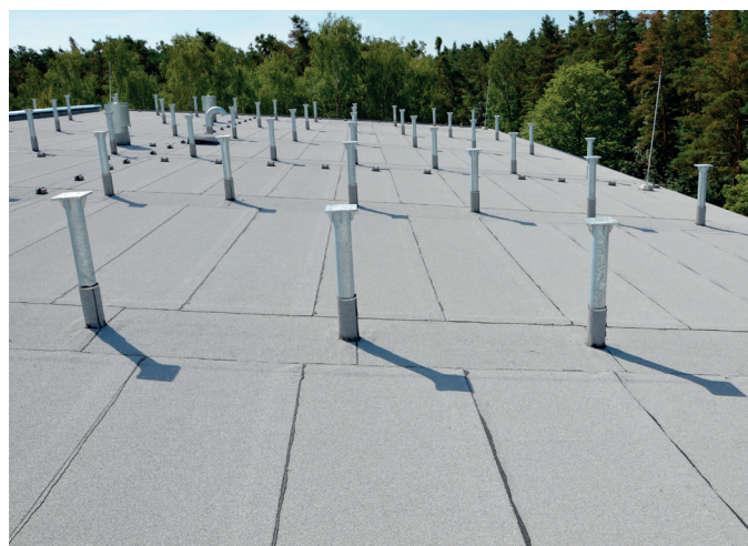
1) Pohled na střechu s modifikovanými asfaltovými pásy s bílým posypem, pomocné konstrukce pro montáž fotovoltaické elektrárny
