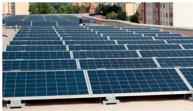
4) Přikotvení fotovoltaických panelů k PVC fólii pomocí systému SolarMount
