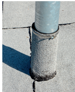
2) Detail, oprava průstupu
